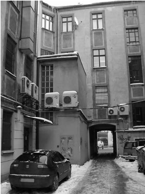
Abb. 4 und 5: Vorder- und Rückseite eines Geschäftshauses in der ul. Piotrkowska (Photo: Erdmann, Januar 2010)
