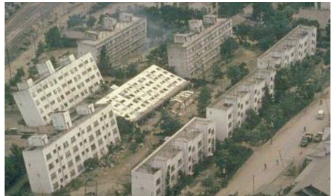
Das passiert, wenn Gebäude auf weichem Unterricht errichtet sind.
