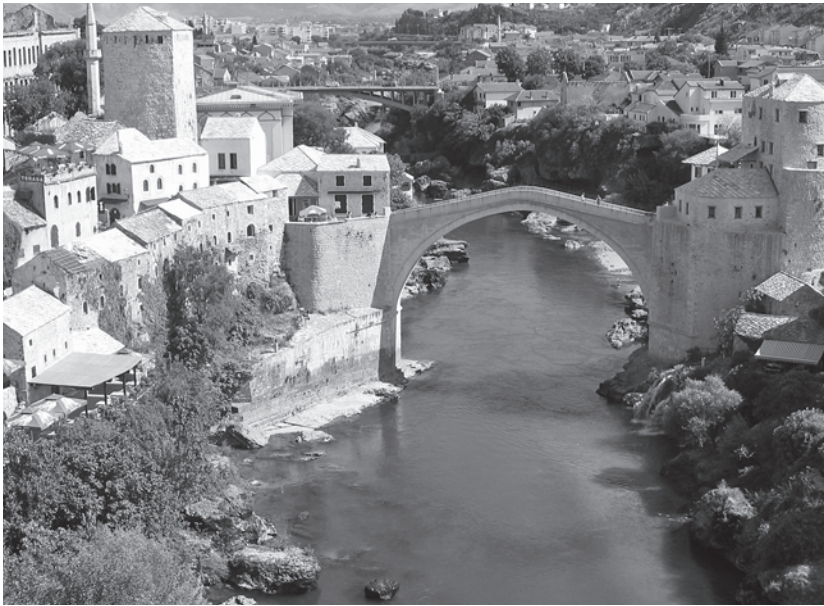
Die im Krieg 1993 zerstörte und 2005 wieder aufgebaute Brücke von Mostar aus dem 15. Jahrhundert als Symbol einer »Brücke« zwischen den Konfliktparteien im Osten und Westen der Stadt
