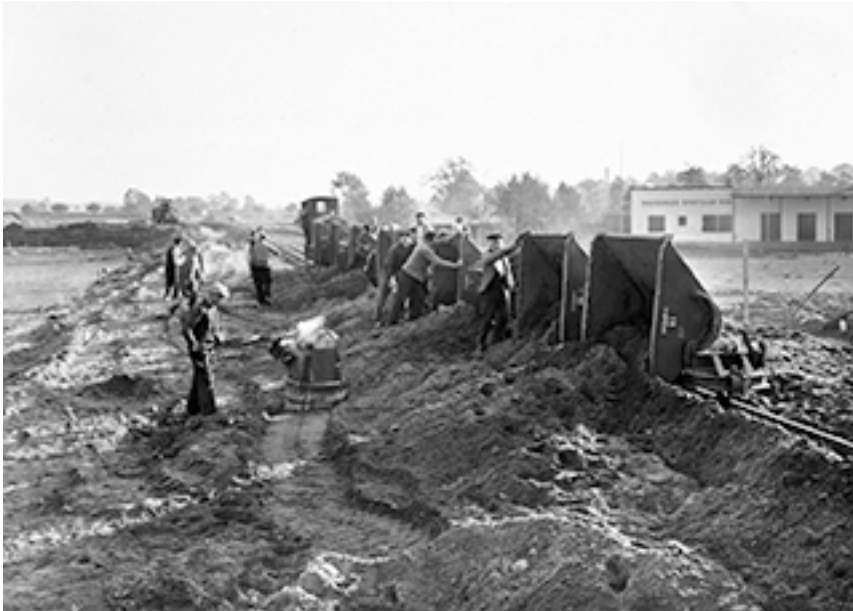
Abb. 2: Reichsautobahn im Bau 1937 in Radeburg (Sachsen), Errichtung eines Damms (4 Meter Höhe) in Handarbeit (SLUB/Deutsche Fotothek, Walter Möbius)
